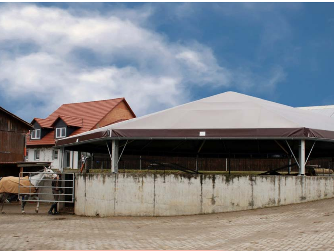
Longierzelt Favorit 16,0 m Sonderanfertigung, montiert auf ausgedientem Silo Dachrinne
